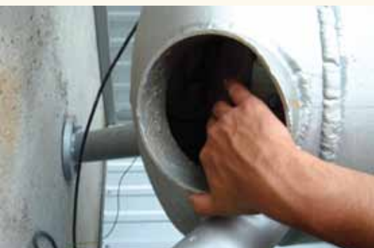
Fot. 5. Dysza do zasysania powietrza atmosferycznego
